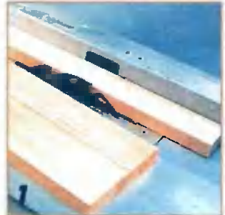
Детали каркаса, карниз и накладку выпиливают из столярных плит толщиной 18 мм дисковой пилой, оснащенной направляющим упором.
