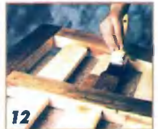
Поверхности створки покрывают средством для защиты древесины или водостойким лаком.
