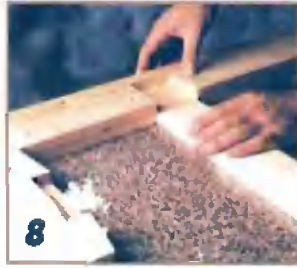
Соединения между отдельными деталями выполняют врубкой вподерева.
