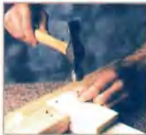
Крепление деталей среднего слоя лучше произвести гвоздями длиной не более 25 мм, а третьего слоя — не более 40 мм.
