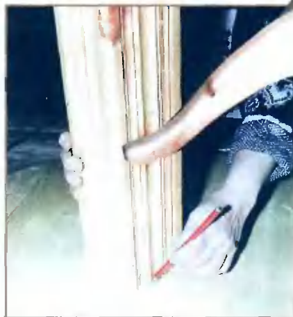
Очерчивание контура посадочного места для соединения ножки и столешницы.
